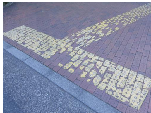
誘導用ブロックの摩耗、劣化
